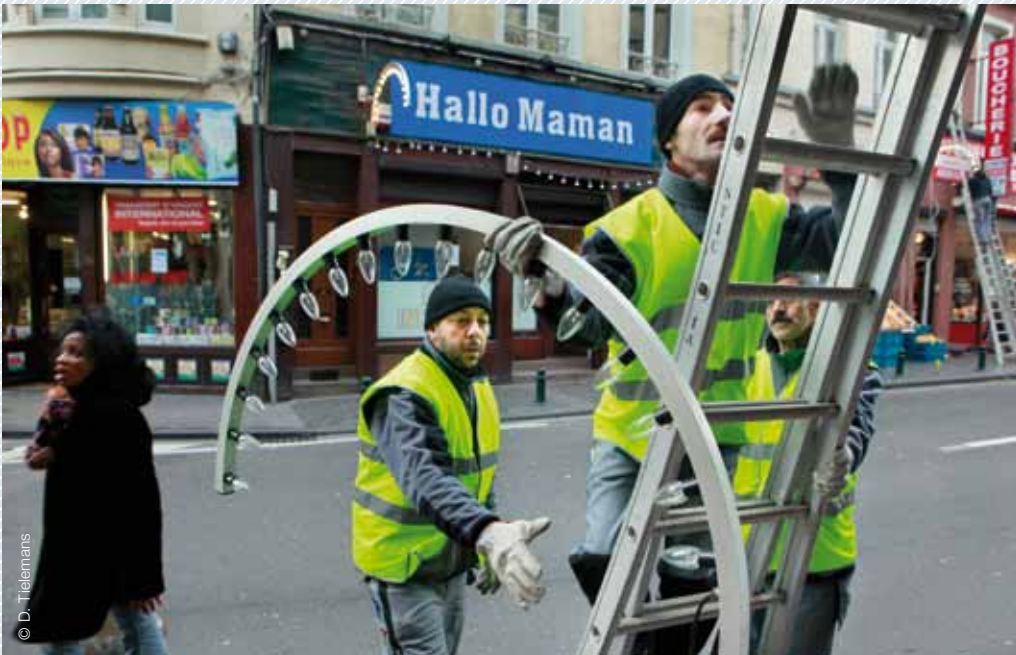
Les anciennes installations ont été retirées
